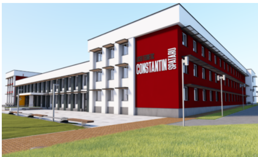
Foto: Proiect de renovare a fațadei, Liceul Teoretic „Constantin Spătaru”
